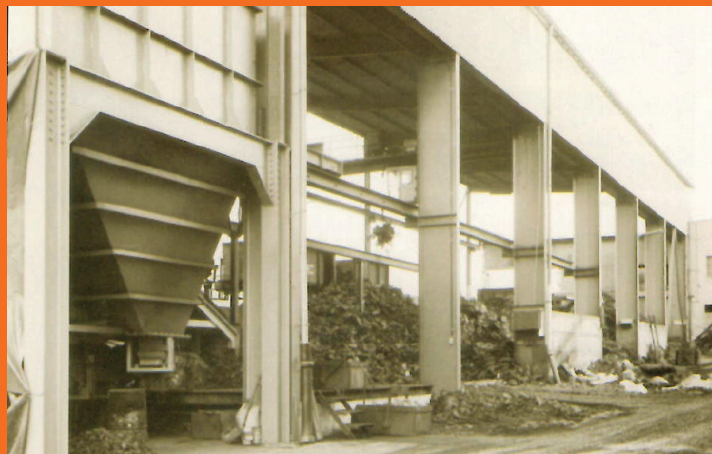
Erweiterung der Gattierungshalle in Wehrstapel
