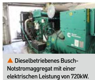
▲ Dieselbetriebenes Busch-Notstromaggregat mit einer elektrischen Leistung von 720kW.
